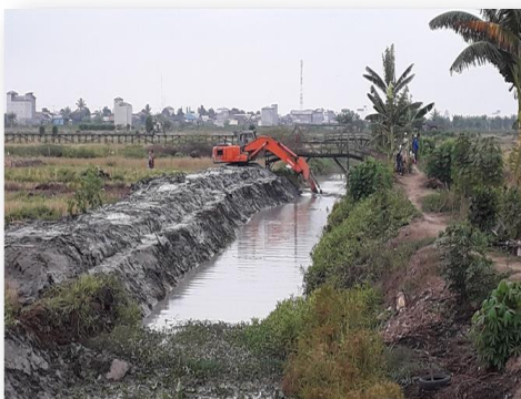
Normalisasi Sungai Watun I Desa Teluk haur Kec.Daha utara
